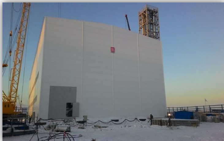
Стационарная котельная установка
